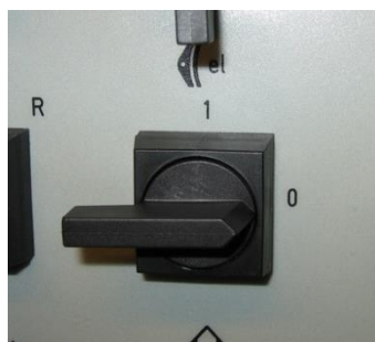
Slika 30: Stikalo ED zavore (v položaju ED izključena)
