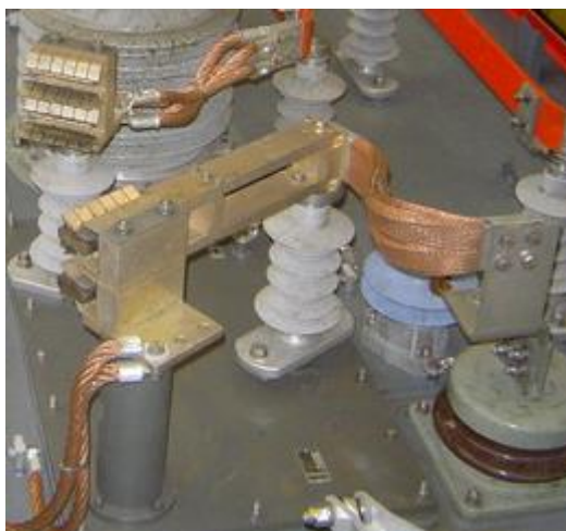
Slika 32: Sistemski ločilnik v položaju »ozemljeno«
