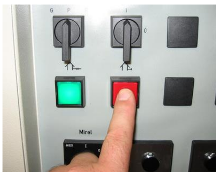
Slika 36: Izklop tujega napajanja
